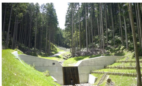
水源地域を守る治山施設
