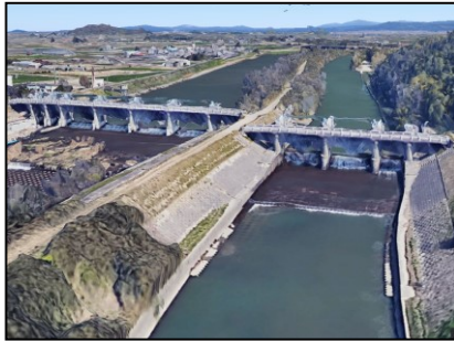
矢作川沿岸 (吉良・古川頭首工)
