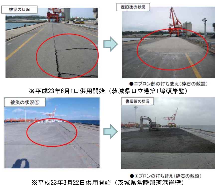
図- 24 【参考写真】岸壁・エプロンの応急復旧事例 (東日本大震災)
