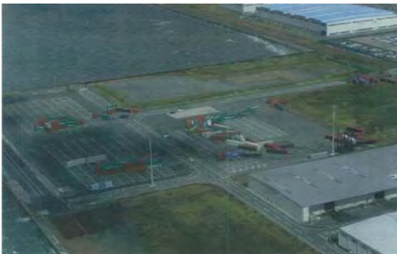
(c) 神野地区8号岸壁
