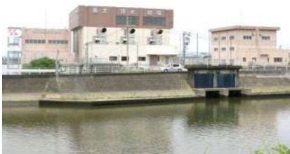
善太新地区(善太新排水機場)
