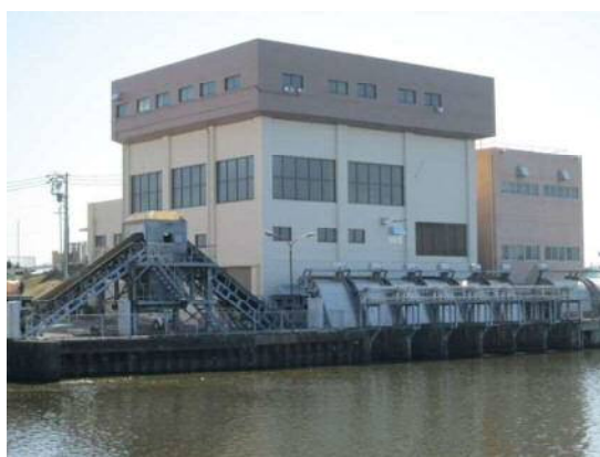
(善太新排水機場)
