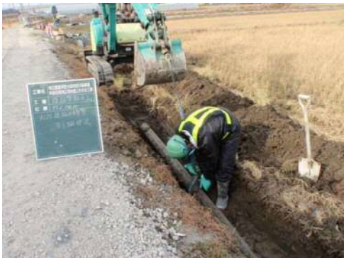
本部田南地区(農業用水管の更新状況)
