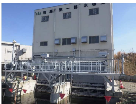
【飛島排水機場の整備】（飛島村）
