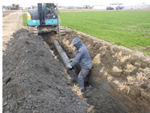
【石綿セメント管の撤去】（弥富市）
