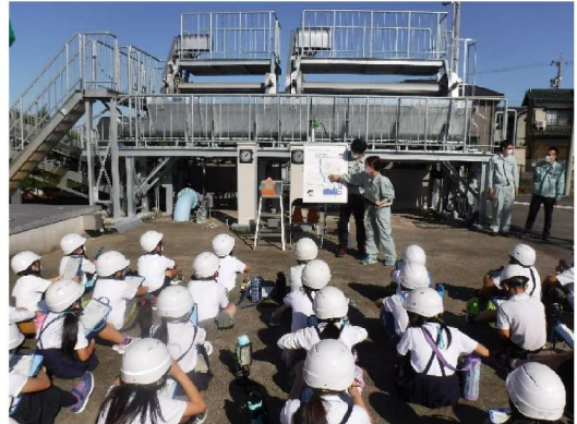
【排水機場での現地学習会】（愛西市）
