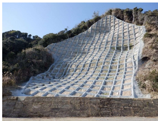
【山地災害から守る治山施設】
