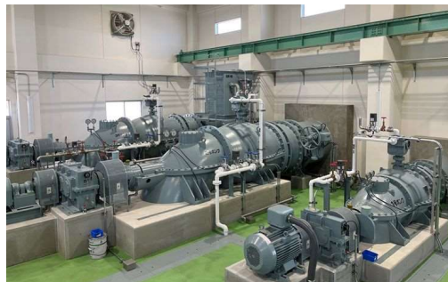
【新天白排水機場（田原市）】
