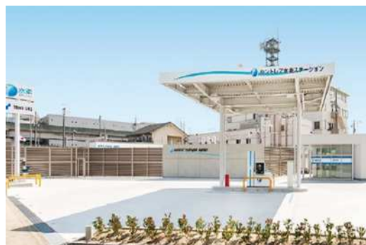
セントレア水素ステーション (常滑市)
