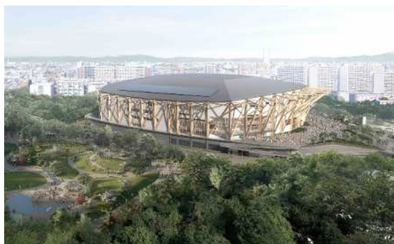
愛知県新体育館（2025 年夏オープン予定） ©2022 Aichi International Arena
