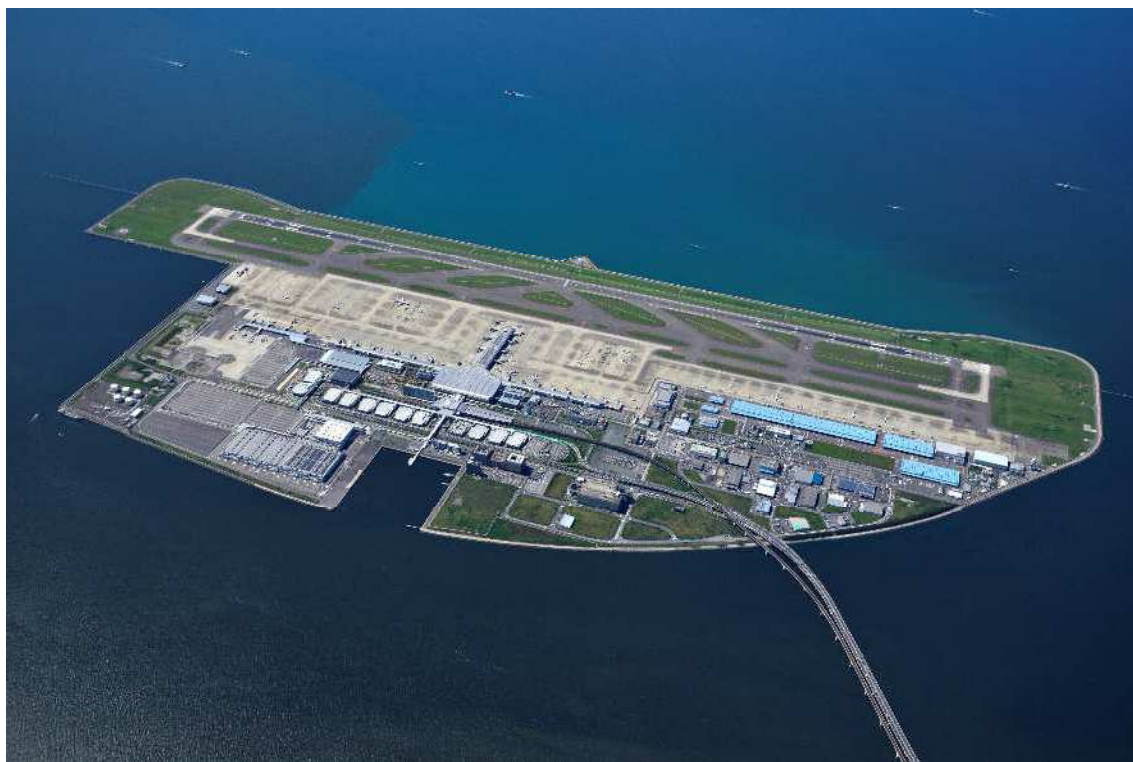
図表 中部国際空港全景
