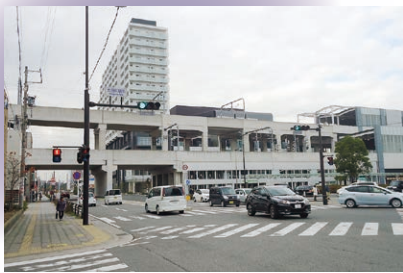
踏切が除却された道路
