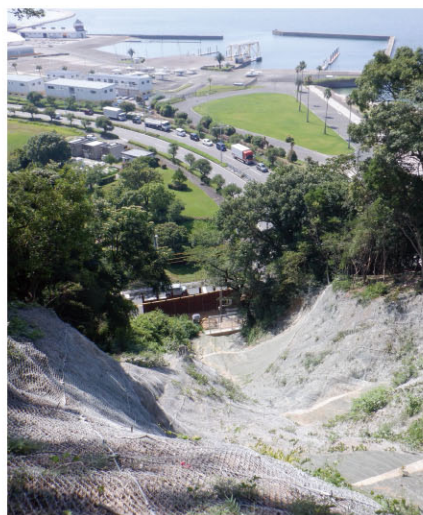
山腹工(蒲郡市)
