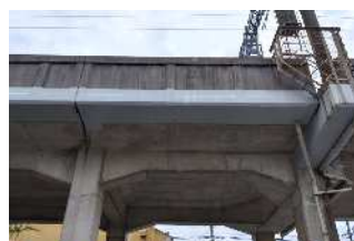
橋梁修繕（剥落防止）
