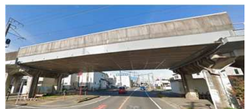
橋梁耐震対策
