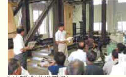
低コスト耐震改修工法の公開実験の様子
