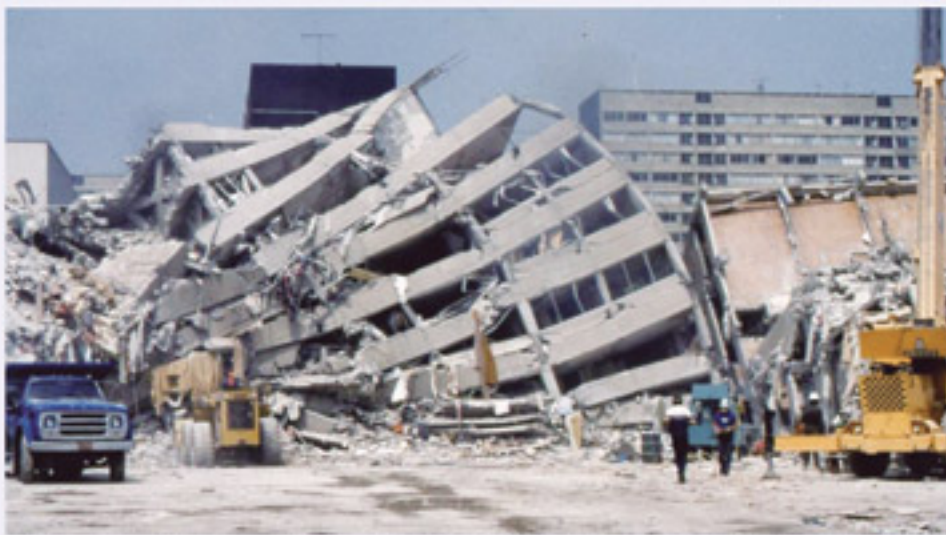
昭和60年メキシコ地震で倒壊した14階建の高層住宅/震源地から400kmも離れたメキシコシティでは、長周期地震動の影響もあり、中高層ビルが多数倒壊した。(撮影 防災情報機構会長 伊藤和明氏)
