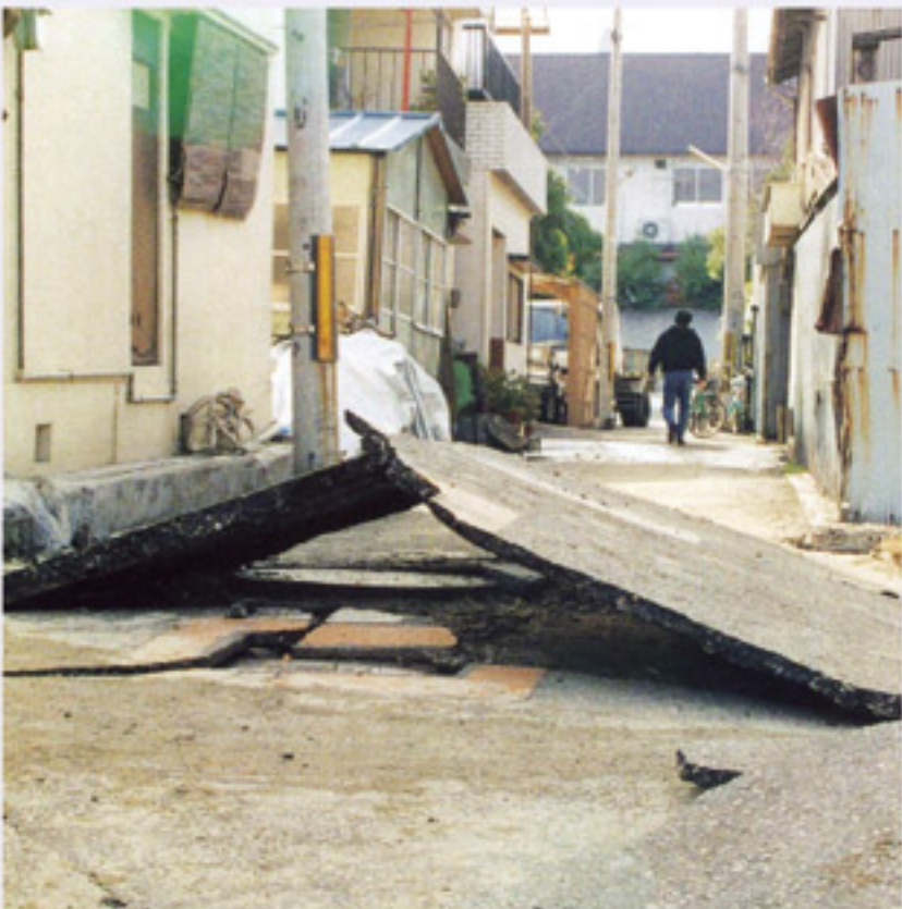
地震の揺れで液状化をおこした砂が噴出し、アスファルトがめくれ上がった道路(平成7年阪神・淡路大震災) 写真提供: 尼崎市
