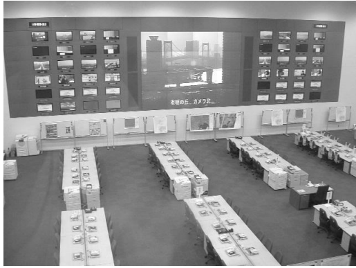
オペレーションルーム
