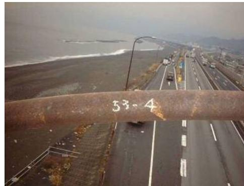
写真-解 8-11 支柱本体の腐食事例
