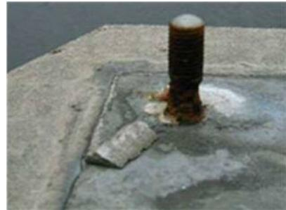
写真・解 6-2 転用部材のアンカーボルトの変状事例
