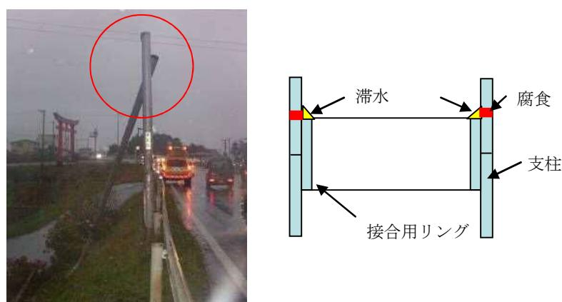
写真・解 8-8 支柱継手部の折損状況
