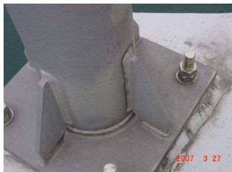
標識柱基部溶接部の亀裂
