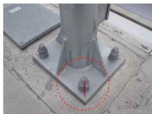
合いマークが見えやすく、かつ、ボルト、ナット、プレートに連続して施工されている。
