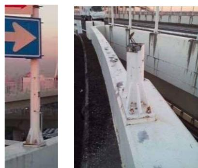
点検用開口部の破断による落下
