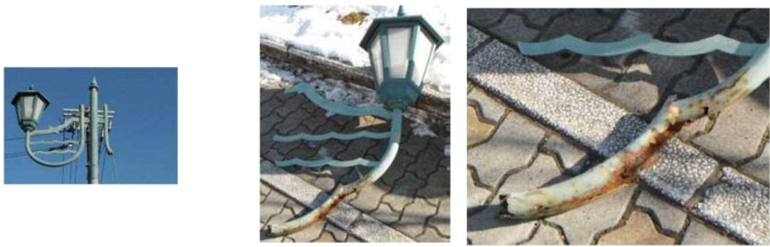
写真-解 3-1 特徴的な部分の腐食が進行した例
