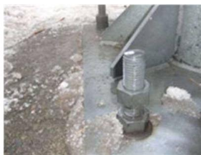
写真-解 6-1 新設後 1 年程度の附属物のアンカーボルトのゆるみ
