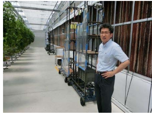
ハウス内を冷やすパット&ファン。水が滴るパットを通った空気が気化熱で冷えて冷熱と湿度を供給。
