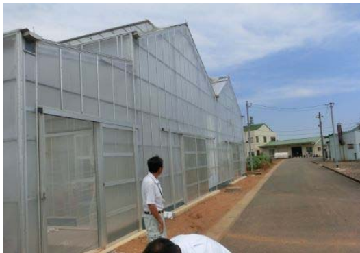
棟高 6,825mm、軒高 4,500mm（いずれも基礎コンクリートを含む）。50m の風速にも耐えられる。
