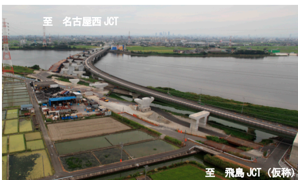
名古屋環状2号線 名古屋西JCT～飛島JCT（仮称） 西南部・南部区間：飛島村（日光川付近）
