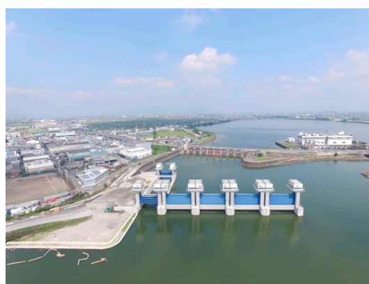
日光川水閘門の改築（2015年8月撮影）
