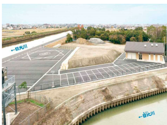
日光川河川防災ステーション
