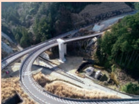
鳳来峡 IC 付近施工状況（2021 年 4 月） （国土交通省 中部地方整備局 浜松河川国道事務所 提供）
