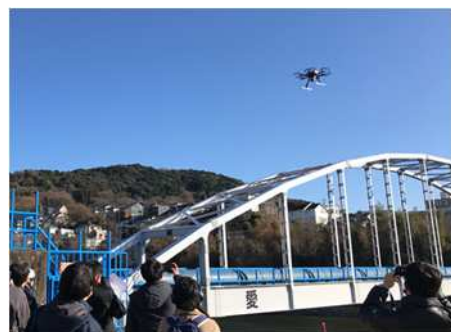
図表4-1-37 ドローンによる水管橋の点検状況
