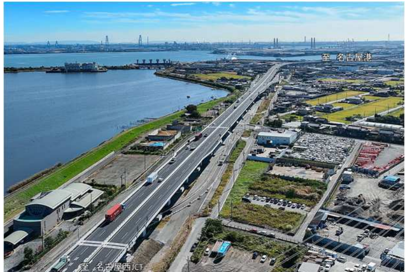
図表4-1-19 名古屋西JCT～飛島JCTの開通
