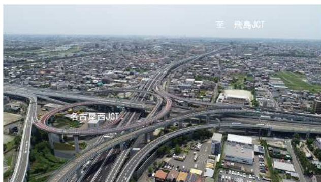
名古屋第二環状自動車道（名古屋西JCT～飛島JCT） 名古屋西JCT
