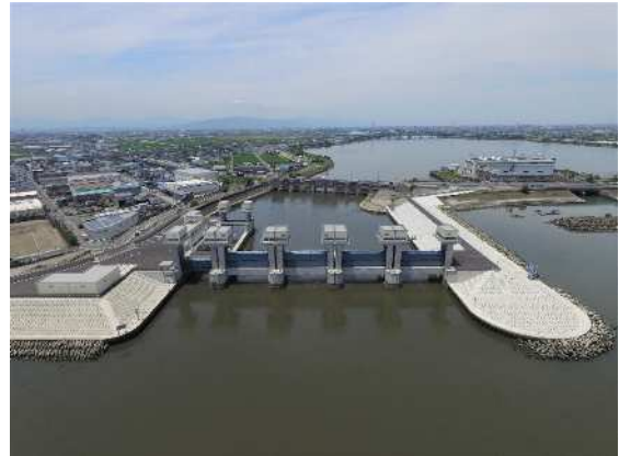
日光川水閘門の改築
