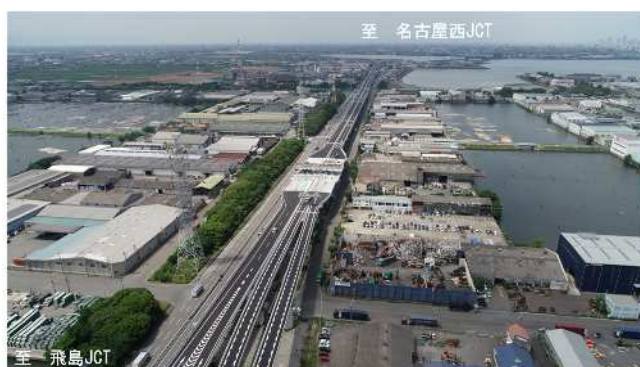
名古屋第二環状自動車道（名古屋西JCT～飛島JCT） 飛島JCT付近
