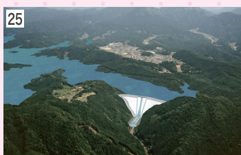
25 設案ダム建設事業
