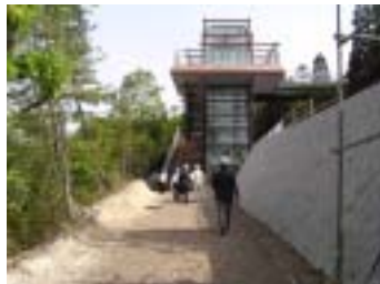
幹線園路エレベータ棟
