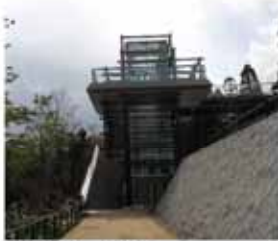
幹線園路エレベータ棟
