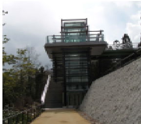
幹線園路エレベータ棟
