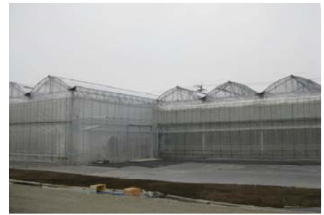
写真3 (株) 誠和 小金井工場の外観
