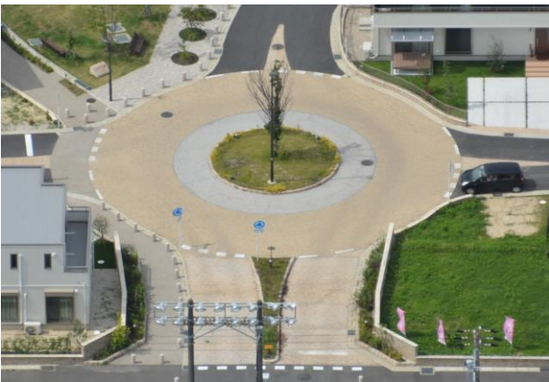
安城市和泉町地内 (和泉公園北側)
