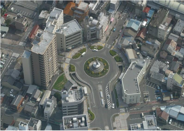
一宮市栄一丁目地内 (一宮駅東約300m)
