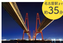
名古屋西大橋
