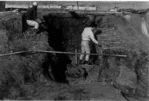
7 8号窯 ステンレス棒、フラットバー枠組保存工事
