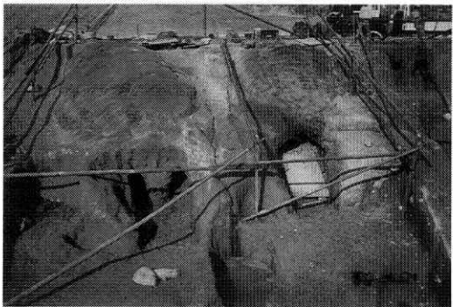
6 9-A、9-B号窯 保存工事（補強・復元工事）完了時
