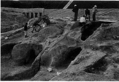
1 9-A、9-B号窯 保存工事開始時
