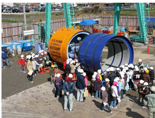
工事現場の見学会 (たん水防除事業 岡崎鹿乗地区)
