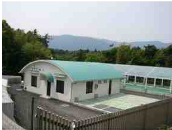
集落排水施設(新城市塩沢地区)
