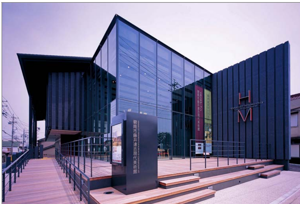
撮影 篠澤建築写真事務所
