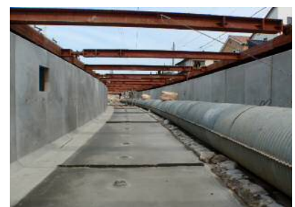
かんがい排水事業中井筋地区 （排水路工事中）
