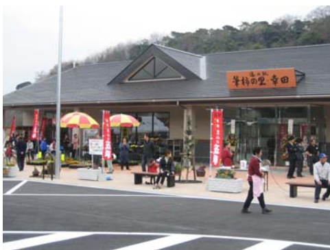
地域振興施設の外観(農産物直売施設側)
