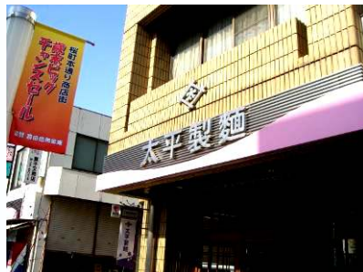
ファサード整備された店舗
