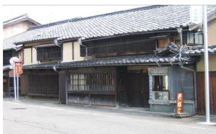
当時の面影が残る建物
