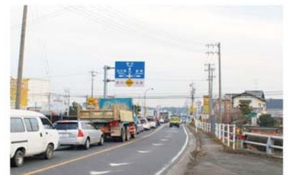
現道踏切渋滞状況（宇頭 12 号踏切付近）
