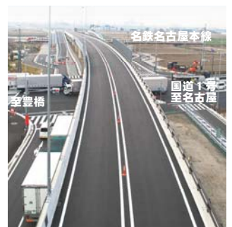
尾崎高架橋より、国道 1 号・名鉄名古屋本線を撮影
