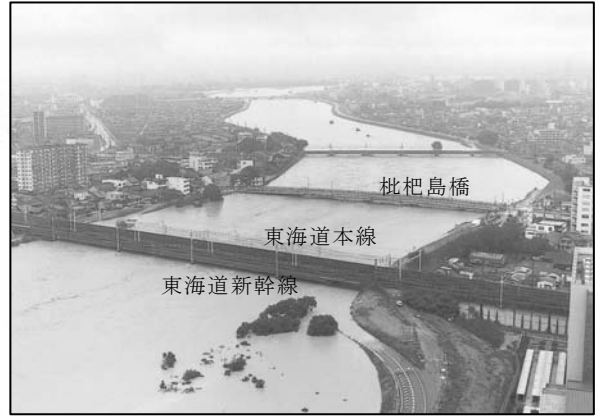
J R東海道新幹線庄内川橋りょう付近 【平成12年東海豪雨時】(名古屋市西区・清須市)
