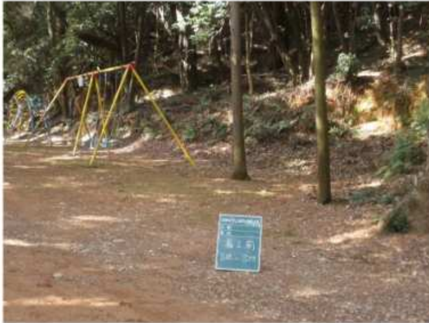
木製土留工施工前
