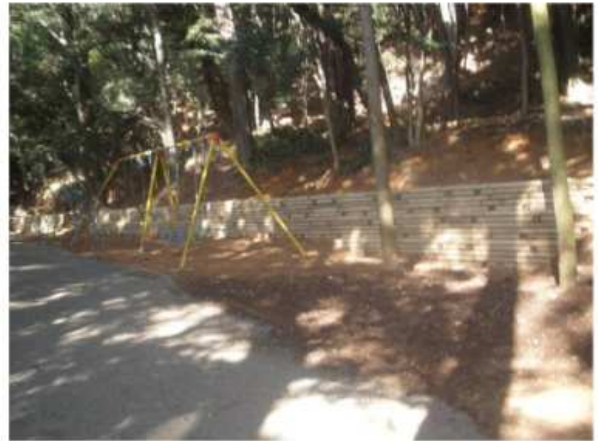
木製土留工施工後
