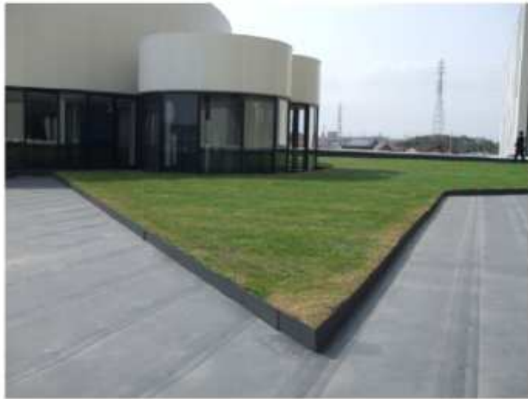
病院屋上 整備後
