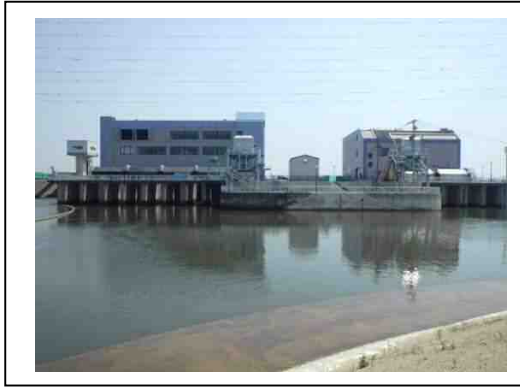
洪水にそなえる排水機場
