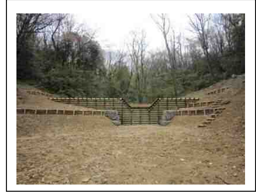
県産材を活用した治山施設
