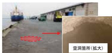
老朽化状況(岸壁の空洞化)
