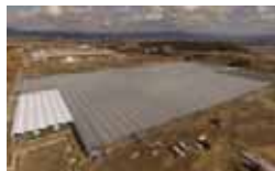
次世代施設園芸 愛知拠点(建設中)
