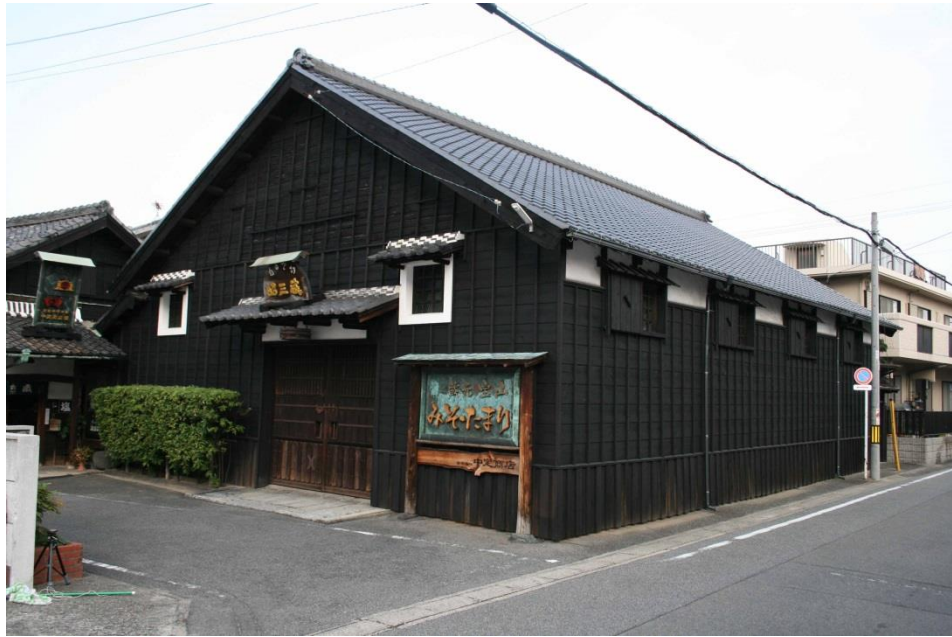
中定商店昭三蔵 南西から（外観）（武豊町教委提供）
