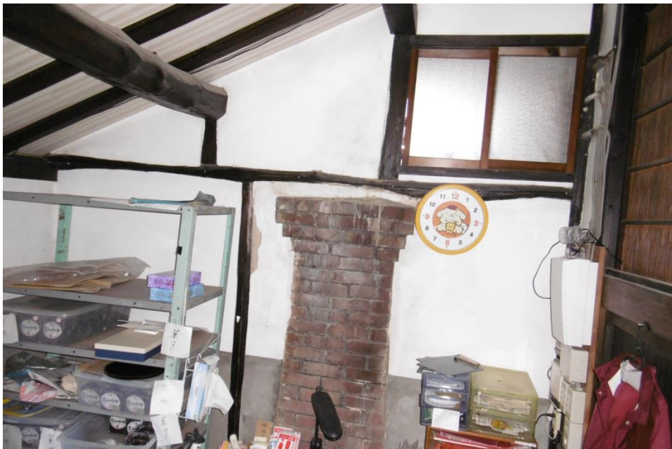
中定商店昭二蔵 事務所北面（武豊町教委提供）
