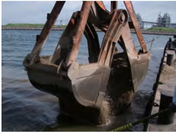
干潟・浅場の造成工事
