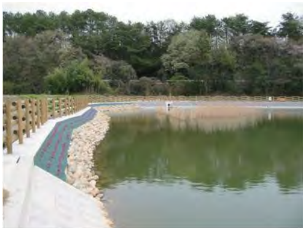
生態系に配慮したため池護岸の整備
