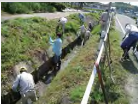
地域の活動組織による農業用排水路の管理作業
