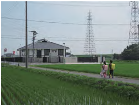
農村の生活排水を処理する農業集落排水施設
