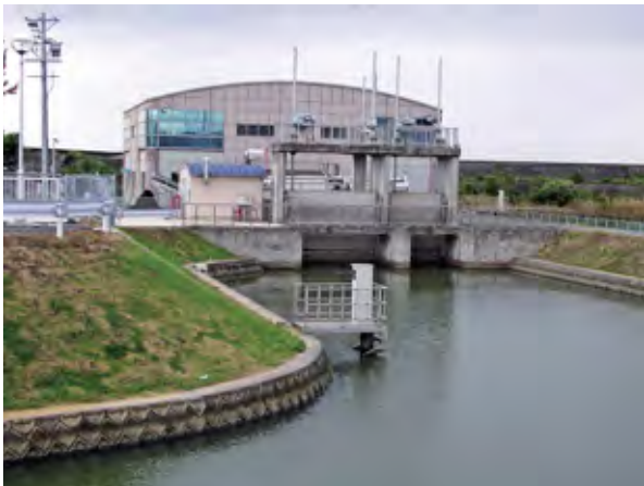
大雨から暮らしを守る排水機場
