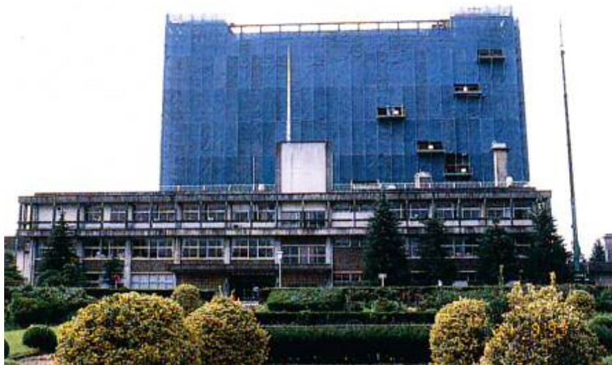
建設中の中央研究棟と旧本館（手前）
