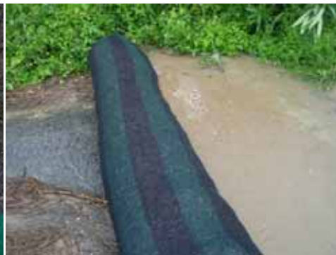
フィルターソックス工法
