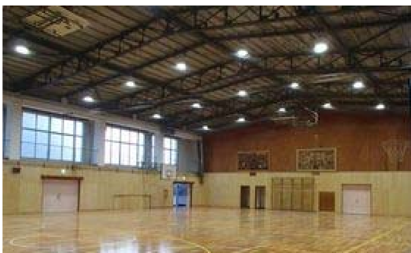
【改修後写真（長久手市東小学校）】
