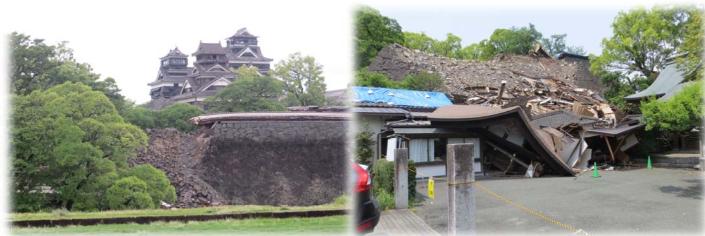
【熊本城の被災状況】
