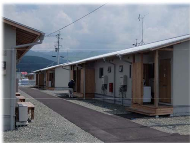
【仮設住宅の建設の様子】
