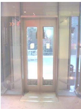
エレベーターの整備例
