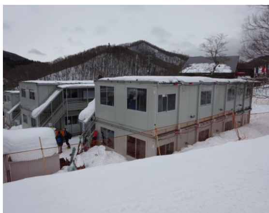
仮設施設（ばんけいスキー場）
