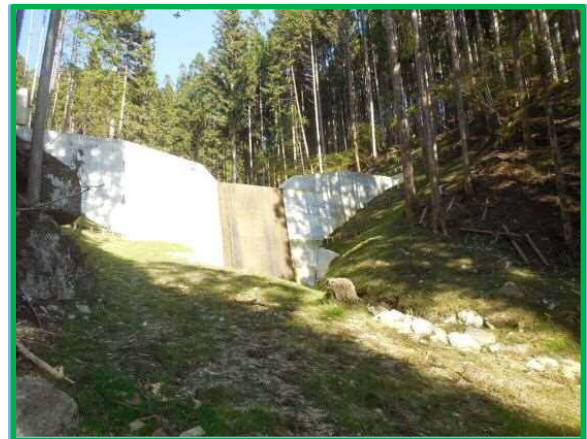
山を守り水を蓄える治山ダム
