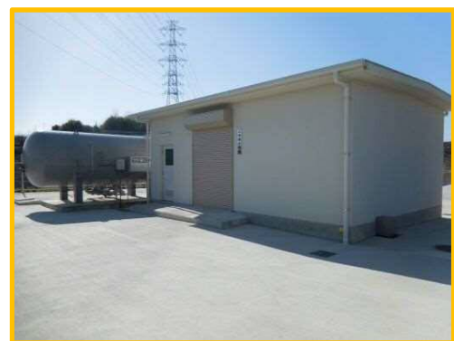
舞木乙部地区(乙部揚水機場)
