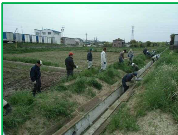
破損した水路の補修
