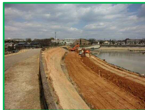
保田ヶ池地区(ため池耐震対策)
