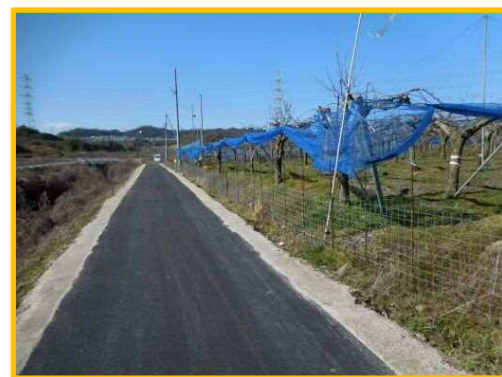
舞木乙部地区(農道舗装)
