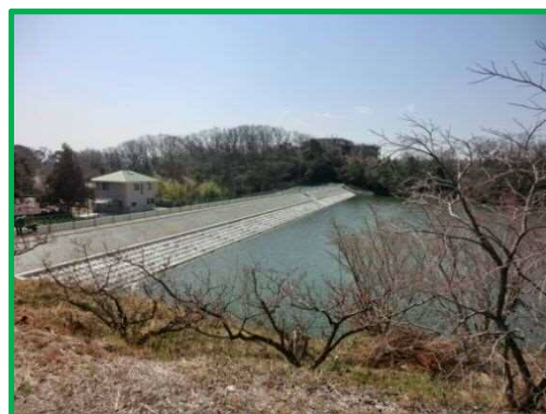
万精池地区(ため池耐震対策)
